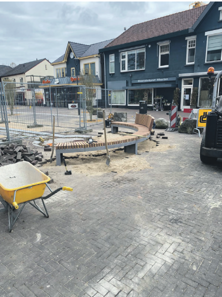
Vrijdag 3 april is deze bank aan het andere uiteinde van het waterkunstwerk geplaatst.
